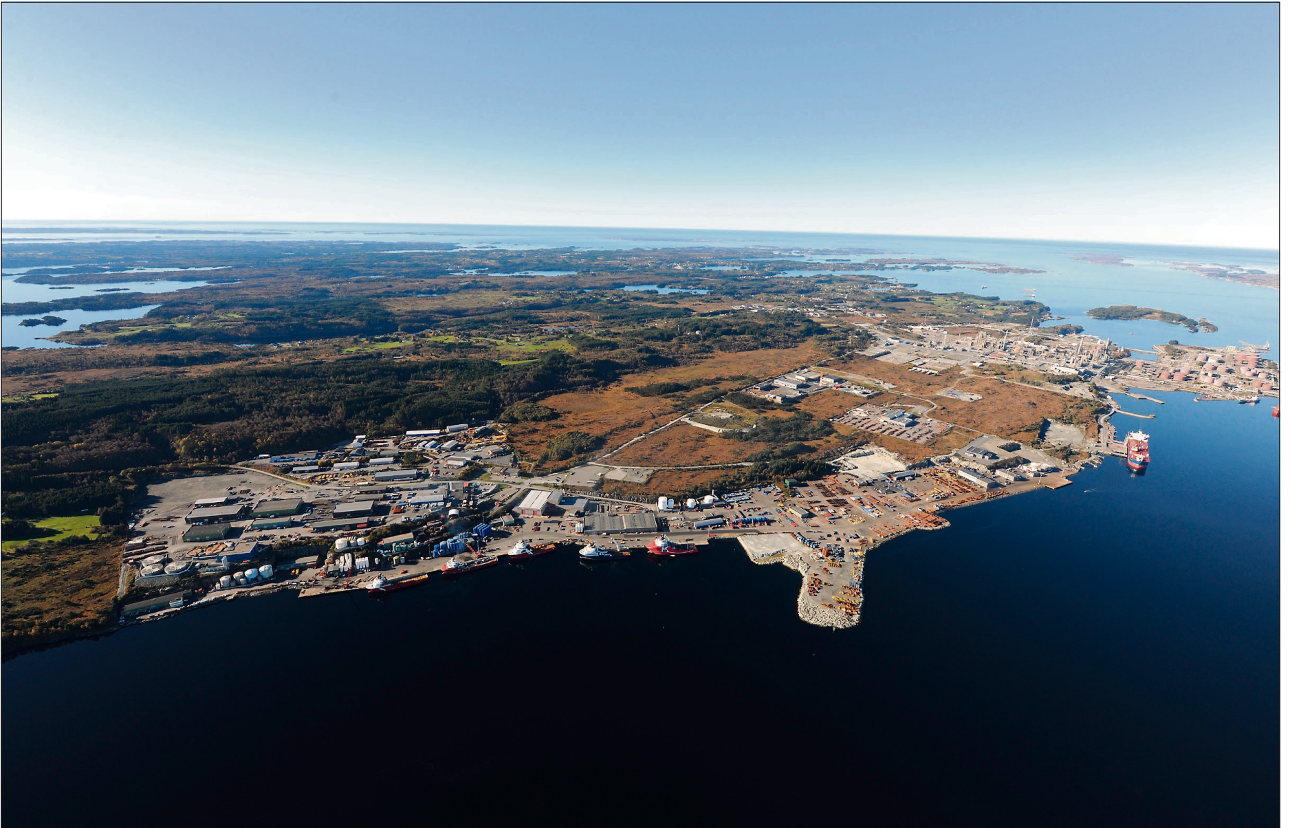
Industriområdet på Mongstad er saman med resten av det ytre Fennsfiordbassenget attraktivt for grønne industriverksemder å etablere seg på. Problemet er å få nok straum ut dit. FOTO: DAG ERIK HAGESÆTER / WIKIMEDIA COMMONS (CC BY-SA 3.0)
